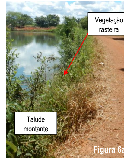
Figura 6 - Presença de vegetação rasteira no talude montante
