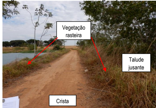
Figura 5 - Crista e taludes com vegetação rasteira
