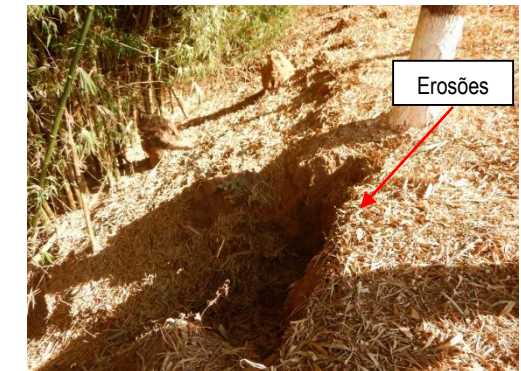
Figura 21 - Talude de montante com erosões
