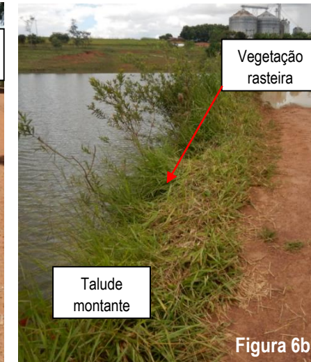
Figura 6 - Presença de vegetação rasteira no talude montante
