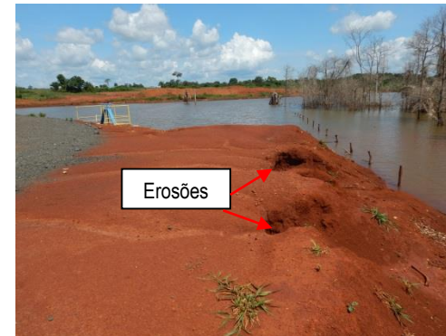
Figura 20 - Erosão Hídrica na ombreira direita
