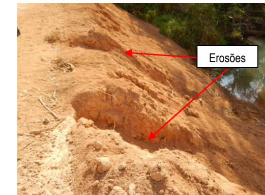
Figura 21 - Talude de montante com erosões
